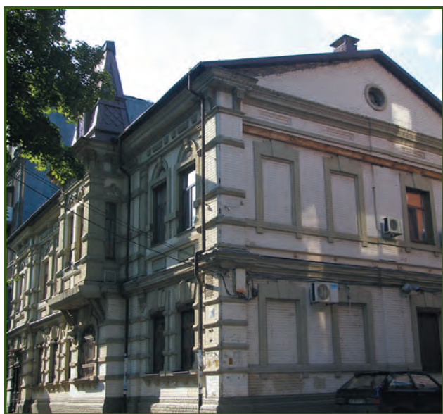
Місто Дніпро. Будинок Івана Езау на вулиці Старокозацькій, 66. Звідси в 1918 році він з родиною вирушив на чужину. Сучасне фото
